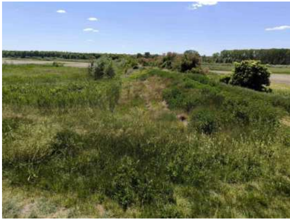
11. fotó: A kábelgát a töltés felől. Az áramlási holtterben a jelentős iszapfelhalmozódás miatt már többéves fásszárú, invazív fajokkal kevert vegetáció található.
